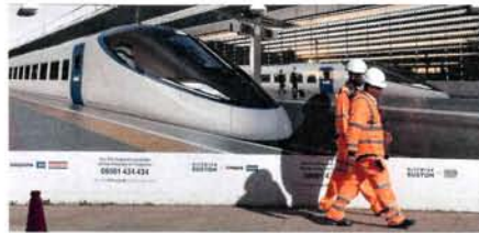
Highspeed – aber nur auf einem Plakat im Hintergrund. Bauarbeiter an der Baustelle für das neue Zug-Projekt Quelle: picture alliance / ZUMAPRESS.com
