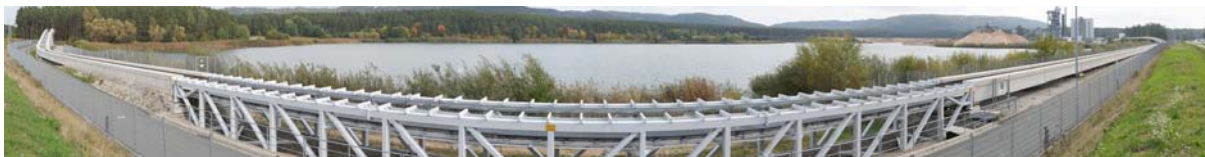
Die 840 Meter lange TSB-Versuchsstrecke entlang der B299 bei Sengenthal (Quelle: Dittmer)
