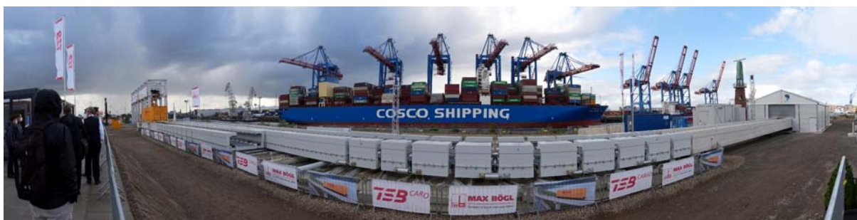
Die 120m lange Strecke Cargo Maglev Demonstrator in Steinwerder (Fotos: Dittmer)
