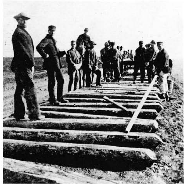
Gleisbauarbeiten der Northern Pacific Railroad, USA um 1880
