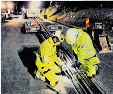
Stromschienen werden in einer Straße eingelassen.
