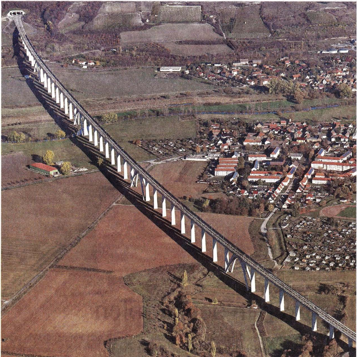
Projekt der Wiedervereinigung: Die Unstruttalbrücke bei Karsdorf wird ab Sonntag von ICE-Zügen befahren.
