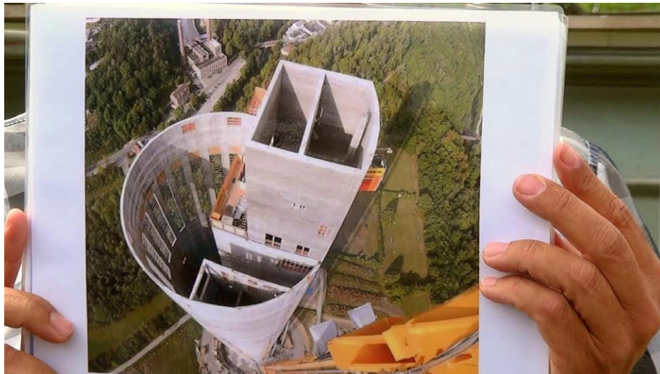
Während einer Baustellenführung August 2017 wird der Baufortschritt von vor zwei Jahren, d.h. vor dem Einbringen der Zwischendecken gezeigt.
