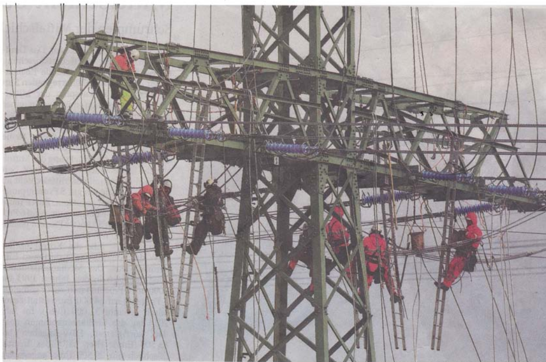
Wichtiger Knotenpunkt: Arbeiten an einem Umspannwerk in Sachsen-Anhalt
