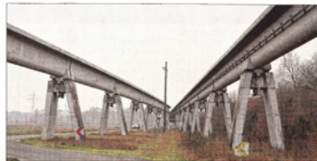
Der Rückbau der Strecke lässt auf sich warten.
