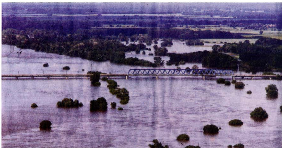
Schon eine einzige Brückensperrung kann einem die ganze Fahrt versauen: Hier bei Tangermünde (Sachsep-Anhalt) kommt vorerst kein Zug mehr über
