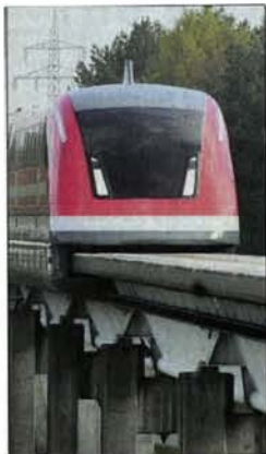
Testbetrieb in Lathen bis Ende 2010 gesichert: Transrapid
