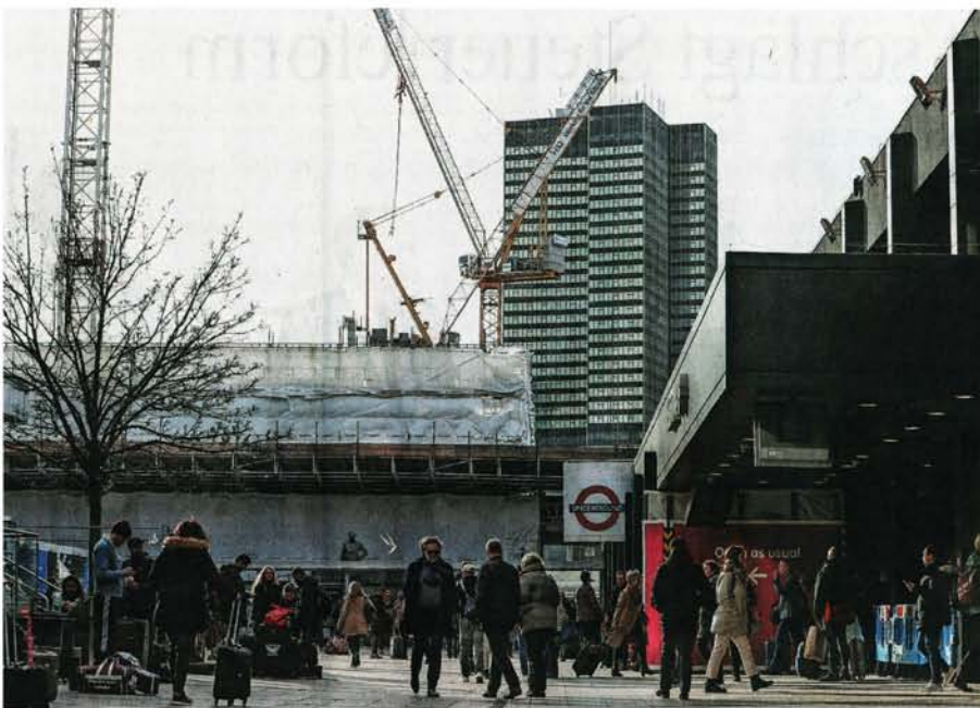
Die Arbeiten für HS2 haben begonnen: An der Station „Euston“ in London ragen Baukräne empor.
